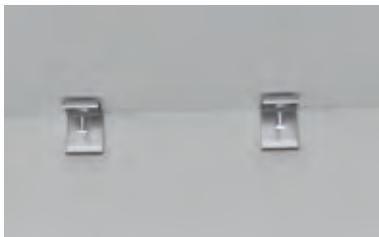
固定安装卡子 Fixed the amounting clip
