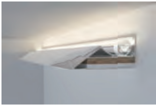
安装灯体 Install lamp body
